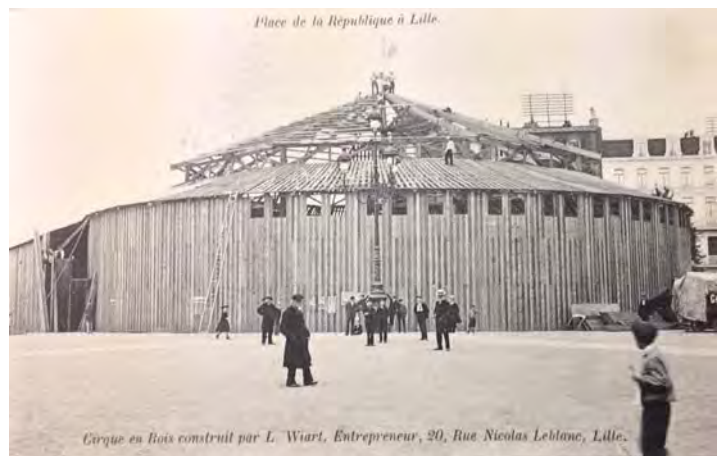
De houten circus'tent' van circus Durandsen hier in Lille in aanbouw
